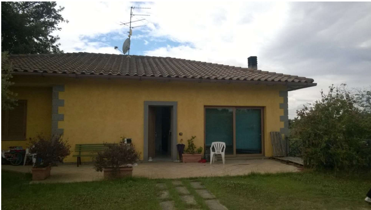
foto 1 – vista ingresso villino da giardino pertinenziale (part.Ila 648)
